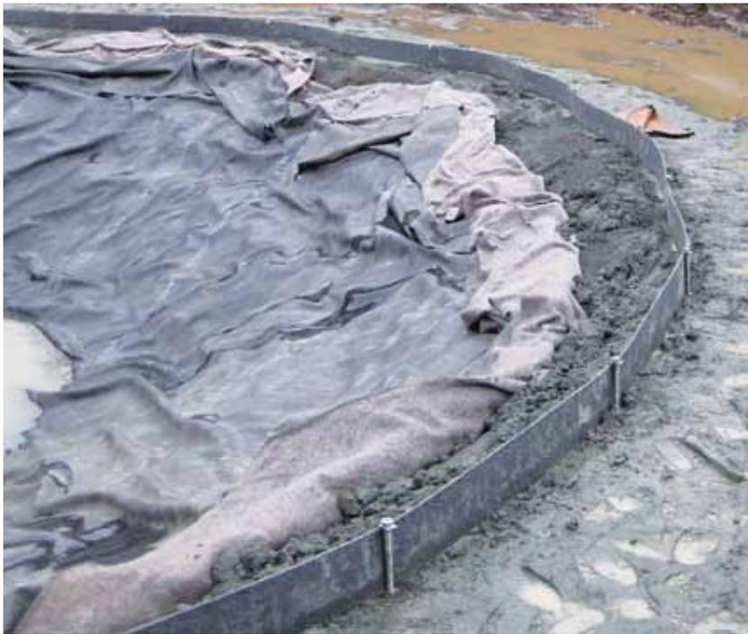
▲ Ein Randstreifen ist biegsam und dadurch kann er der Uferlinie optimal folgen. An Gewindestangen befestigt kann eine exakte Nivellierung erfolgen.
