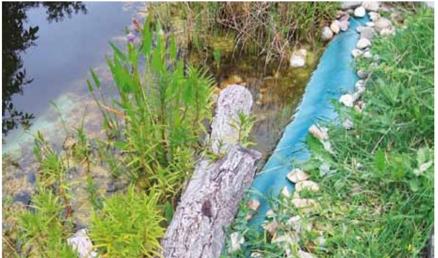
▲ Nackte Folienwälle sind unschön, den Gartenwerkzeugen schutzlos ausgeliefert und altern in der UV-Strahlung des Sonnenlichts rasant.
