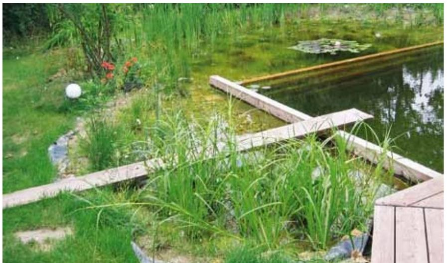
▲ Hier darf sich die Folie frei entfalten. Die Gefahr ist, dass sie von Pflanzen überwuchert wird und sich somit kapillare Zugschichten bilden.
