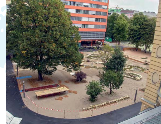
Mäandrierender Bach im Schulgarten, direkt nach Fertigstellung
